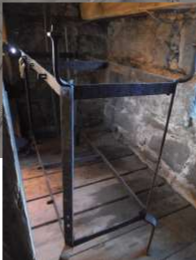
Uhrrahmen vor der Demontage im Kirchturm 14.12.2017
