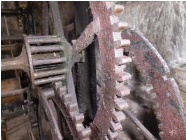
Detail aus dem Schlagwerk mit starkem Rostansatz (Turmfenster) 05.05.2014
