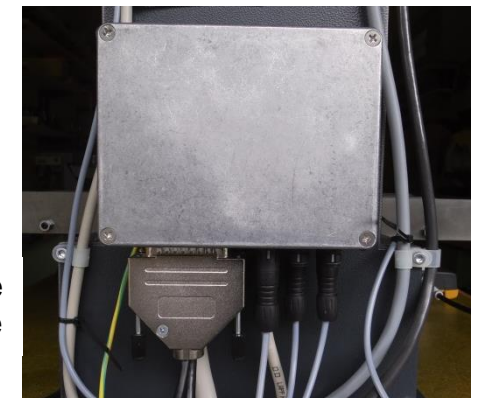
Steckeranschlüsse an Verteildose
